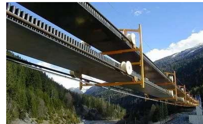
搬送コンベヤ
