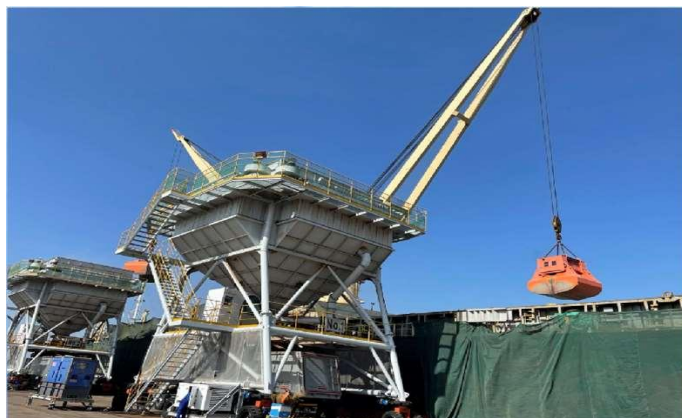
ペレット燃料荷卸し作業中
