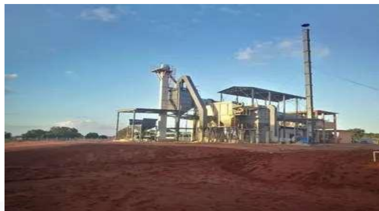
木質ペレット生産ライン
