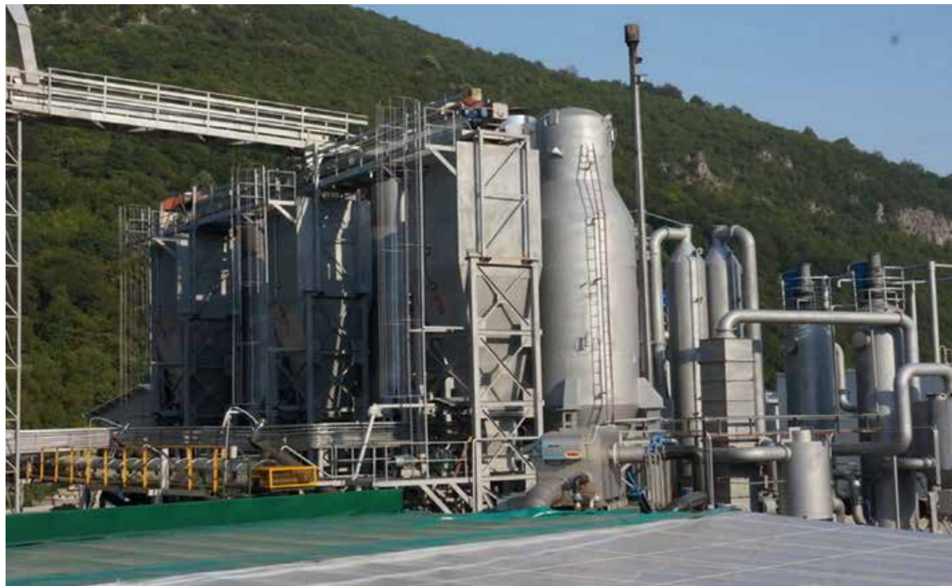
2MW バイオマスガス化発電所
