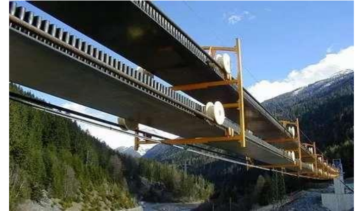
搬送コンベヤ
