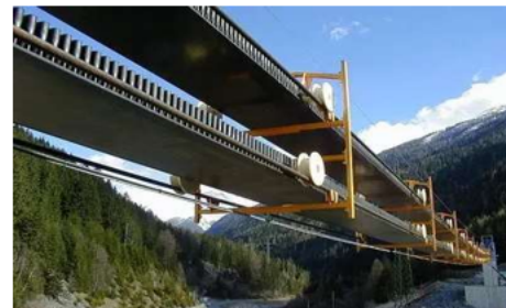
搬送コンベヤ
